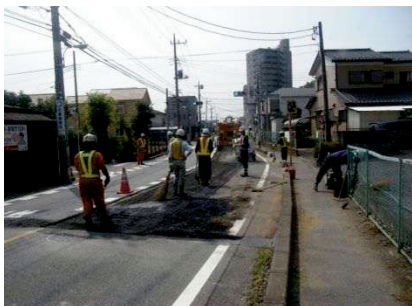
区内の道路修繕の様子
